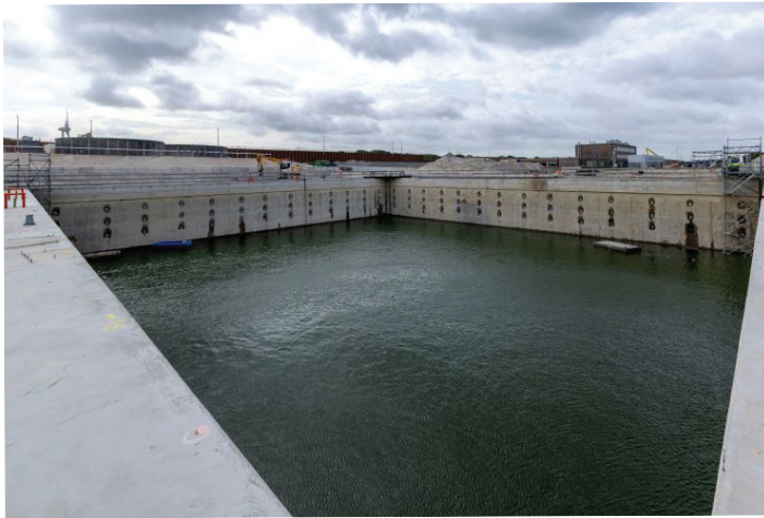
De Pit & Foundation van de nieuwe reactor
