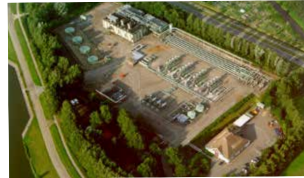
Situatie ca. 1985, met 4e droogtrein, 4e fornuis, 2e slugcatcher, nieuwe controlegebouw en compressorgebouw
