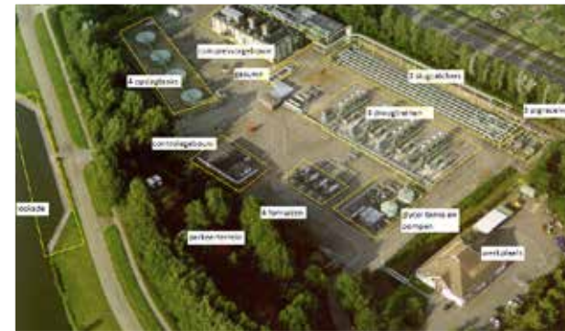
Ca. 2023 waarbij 3 droogtreinen, 3 fornuizen, glycol tanks, koelers en pompen zijn verwijderd. De E-compressor met E-container staan linksboven. De regenwaterbak en bluswaterinlaat was al bestaand.
