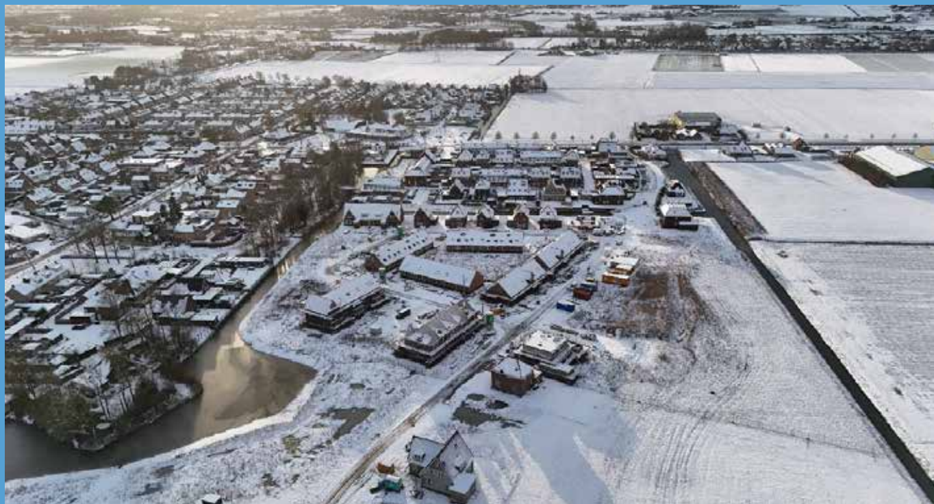
Figuur 2: 't Veld Noord fase 2.1 in aanbouw (januari 2026)
