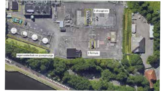
2025, bovengrondse installaties zijn al verwijderd, bodemsanering is gestart (rode installatie), werkplaats is nog in gebruik als kantoor en kantine, trafohuisjes en pomp-huisje staan er nog.
